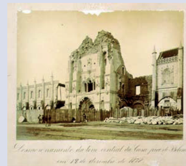
Fig. 17 Desmoronamento parcial da Torre Oca do actual Museu Nacional de Arqueologia (fotografia de 1878)
