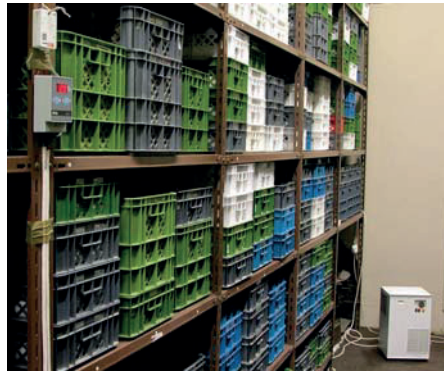
Fig. 112 Reserva de metais onde o controlo ambiental é efectuado usando desumidificadores que asseguram valores próximos de 30% de humidade relativa durante todo o ano
