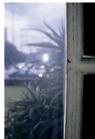
Fig. 47 Filtro ultravioleta aplicado no vidro de uma janela
