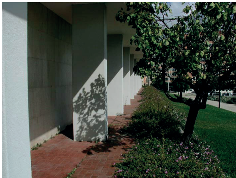
Fig. 118 Área livre de vegetação em redor do edifício do museu
